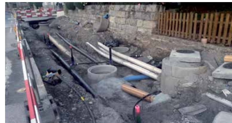
pose des conduites eau potable, gaz, électricité, égoût, juin 2015
