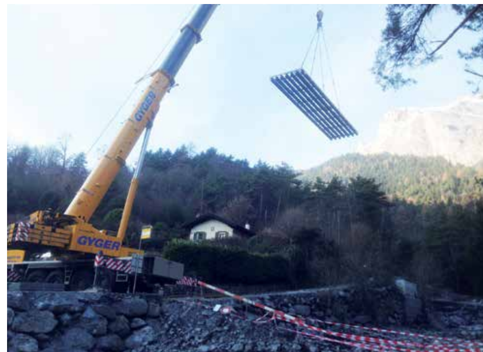
Le pont situé aux Prés du Mayen avait été dévasté par les intempéries du 24 juillet. Le 14 décembre, le tablier est mis en place, et quelques jours plus tard, le nouveau pont sur le torrent de Cry est terminé.
