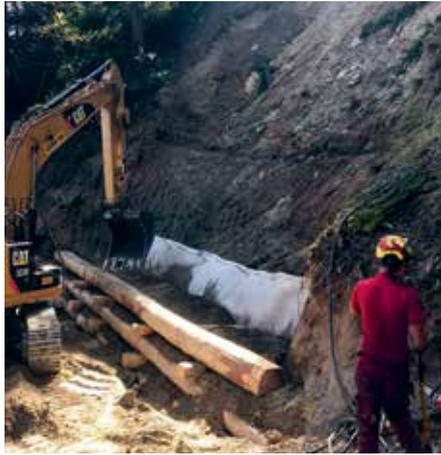
Mise à mal par les intempéries, la route forestière conduisant à l'Ardèche a été réparée à l'aide de caissons de consolidation de 135 et 100 m<sup>3</sup>, fabriqués avec du mélèze de la région.
