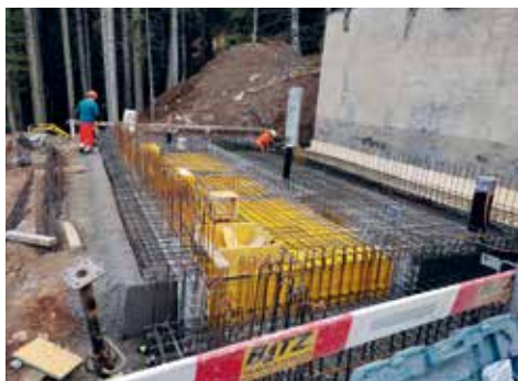
Les centrales d'ultrafiltration, pour de l'eau potable aux Mayens et à Loutze, seront inaugurées en juin 2022.
