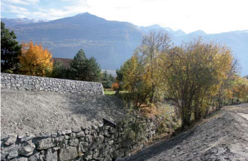
Au Grugnay, le réaménagement et la sécurisation du lit du torrent en lieu et place du pont.
