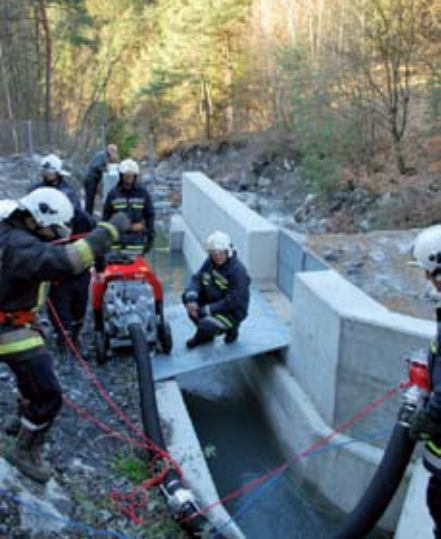
La mise en place de la machine pour l'aspiration dans la Lozentze.
