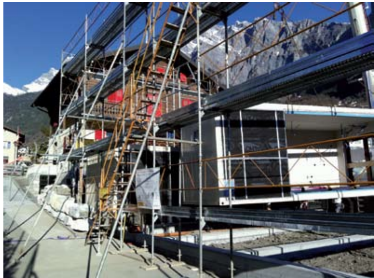
situation au 5 février 2011 pendant le montage de la nouvelle structure
