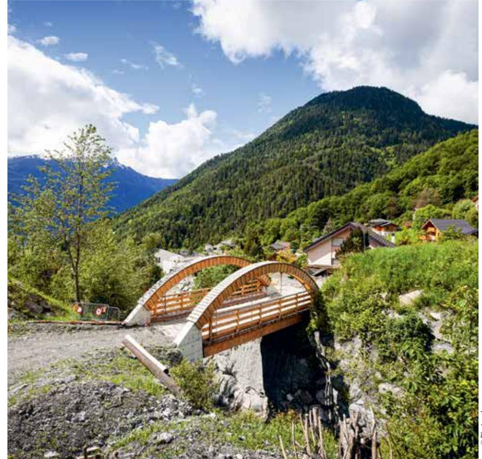
Construite en mélèze, la nouvelle passerelle de Champ Neuf est un pont fusible: en cas de crue, les cintres resteront en place, et le tablier pourra être emporté et se disloquer sans risque.
