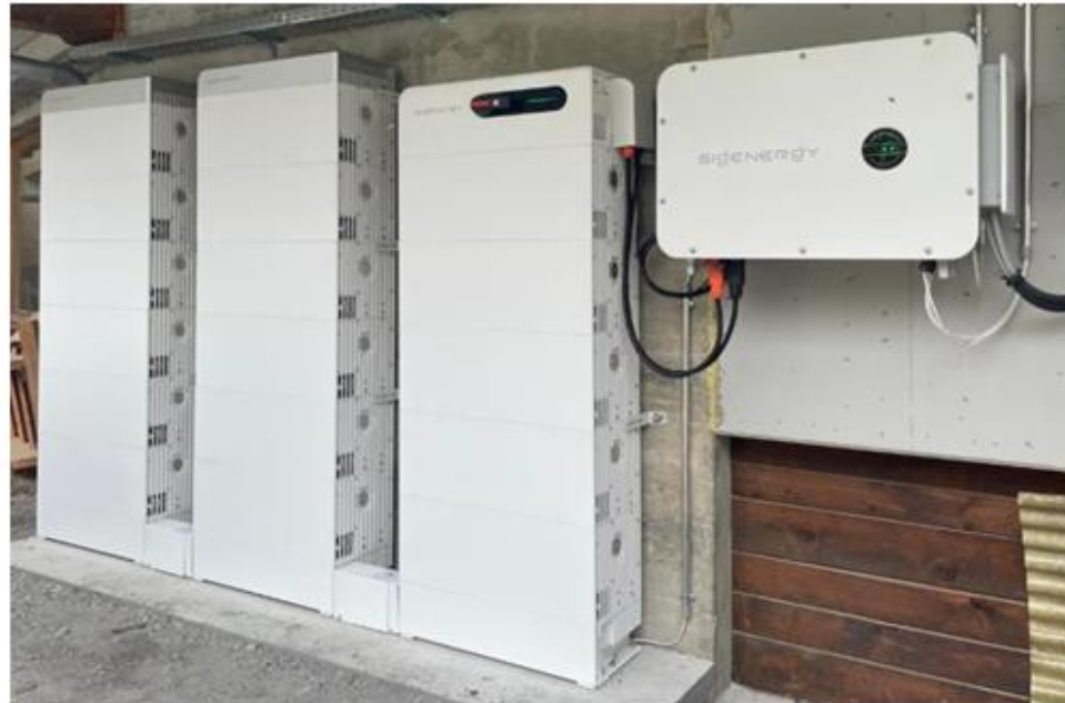
Installation de batteries de stockage - 205 kWh
